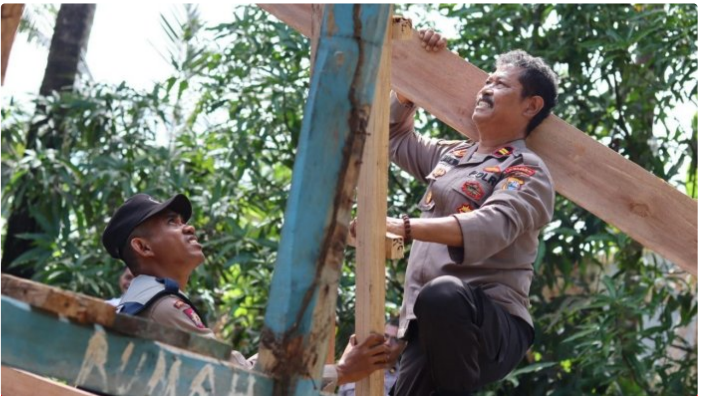
Personil polres Barru saat sedang melakukan pekerjaan bedah rumah
